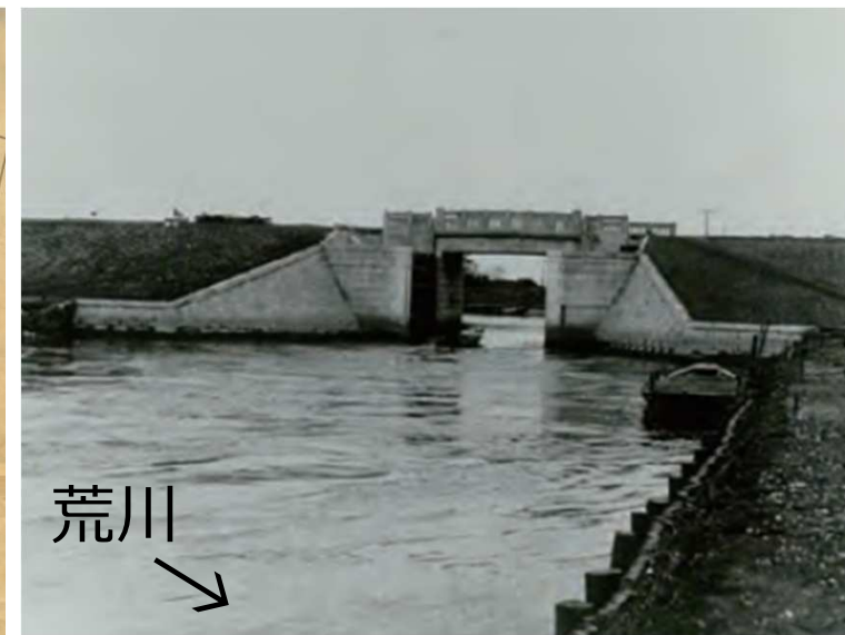
中川水門(大正12年度竣工)
